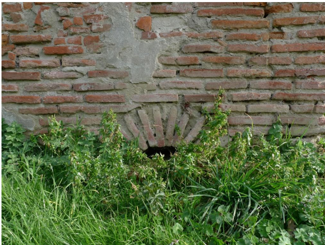
Figure 38 : Système d'évacuation (?) en bas de la façade, vers l'est.
