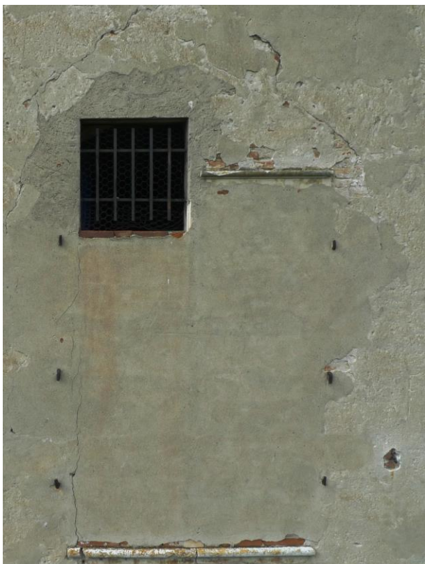
Figure 55 : Croisée ouest murée (FEN 2607)
