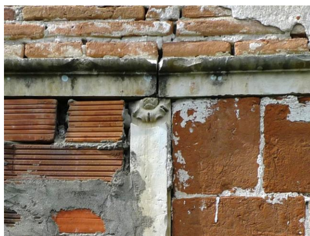
Figure 58 : Détail du décor sur le meneau d'une croisée (FEN 2505).
