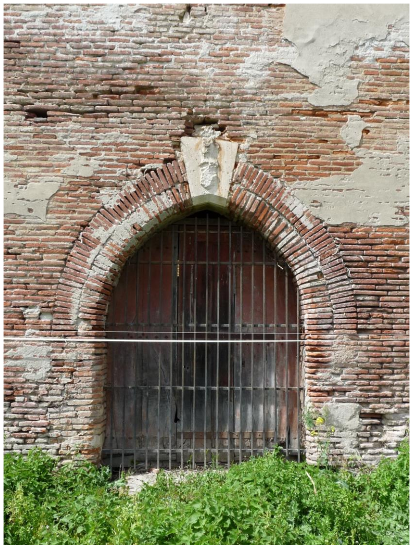
Figure 54 : Portail principal en arc brisé (POR1404)
