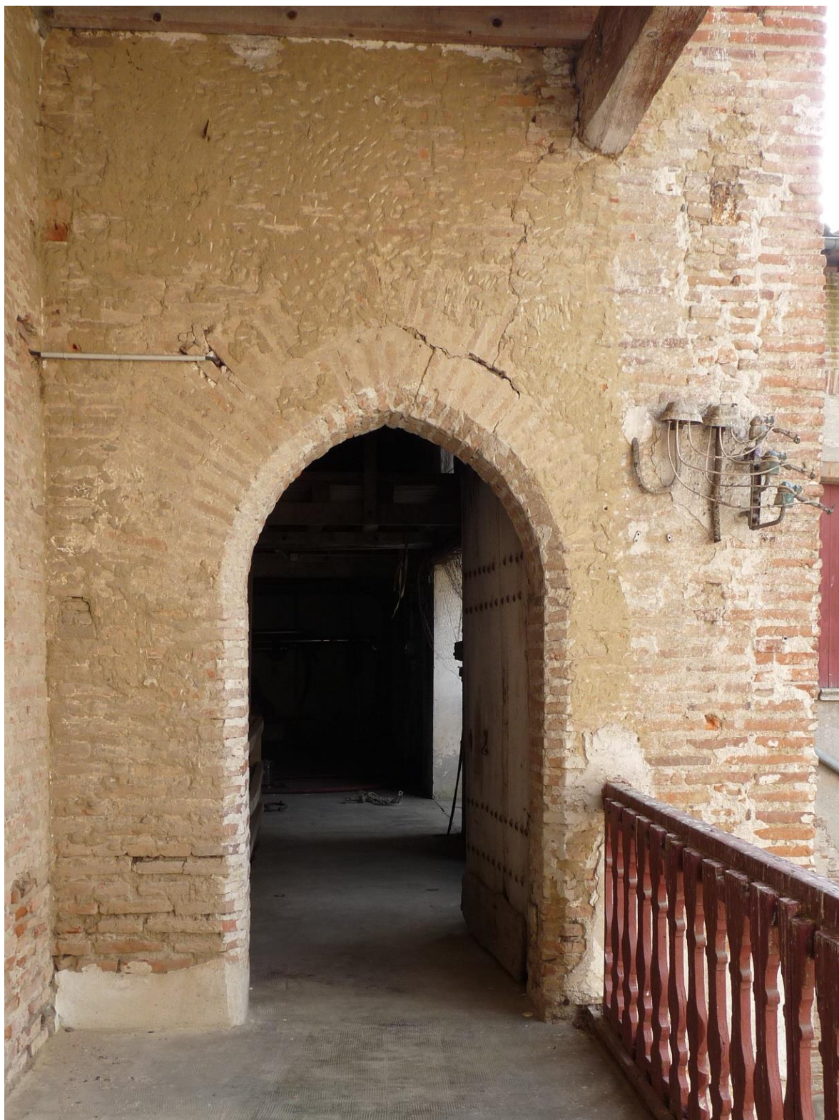
Figure 87 : Accès principal à la pièce (POR 2504) depuis la galerie (GAL 29). Cl. L. Gérardin.
