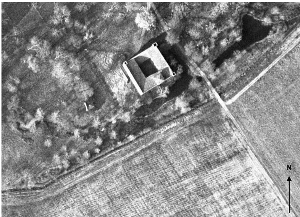
Figure 4 : Vue aérienne, 15 février 1961, détail.
