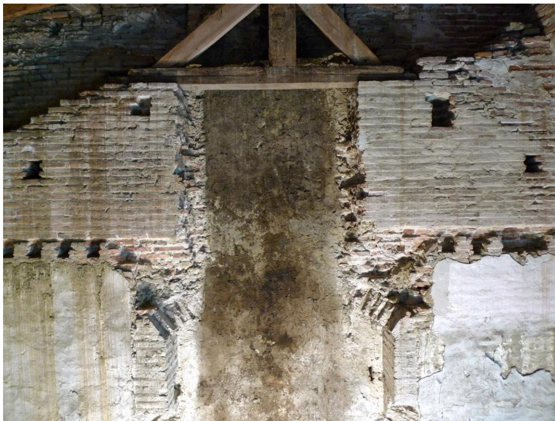
Figure 84: Traces d'une cheminée (CHE 2306) inscrite dans l'arrière-voussure cassée d'une ancienne fenêtre jumelée bouchée.
