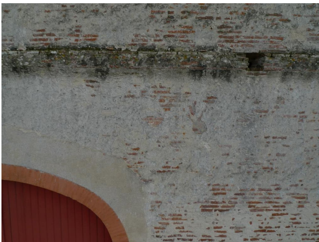
Figure 41 : Cordon d'appui sur la partie ouest de la façade.
