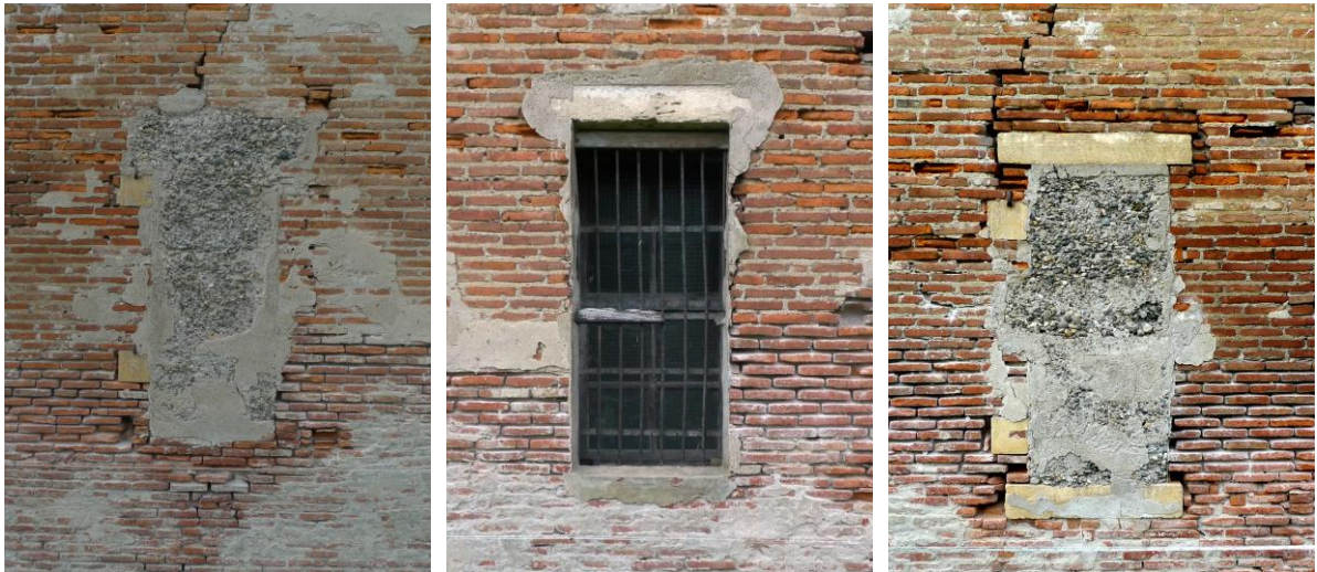
Figure 52 a, b, c : Série de trois fenêtres au rez-de-chaussée, à gauche/ouest de la façade, de gauche/ouest à droite/est (FEN 1607, 1606, 1605).
