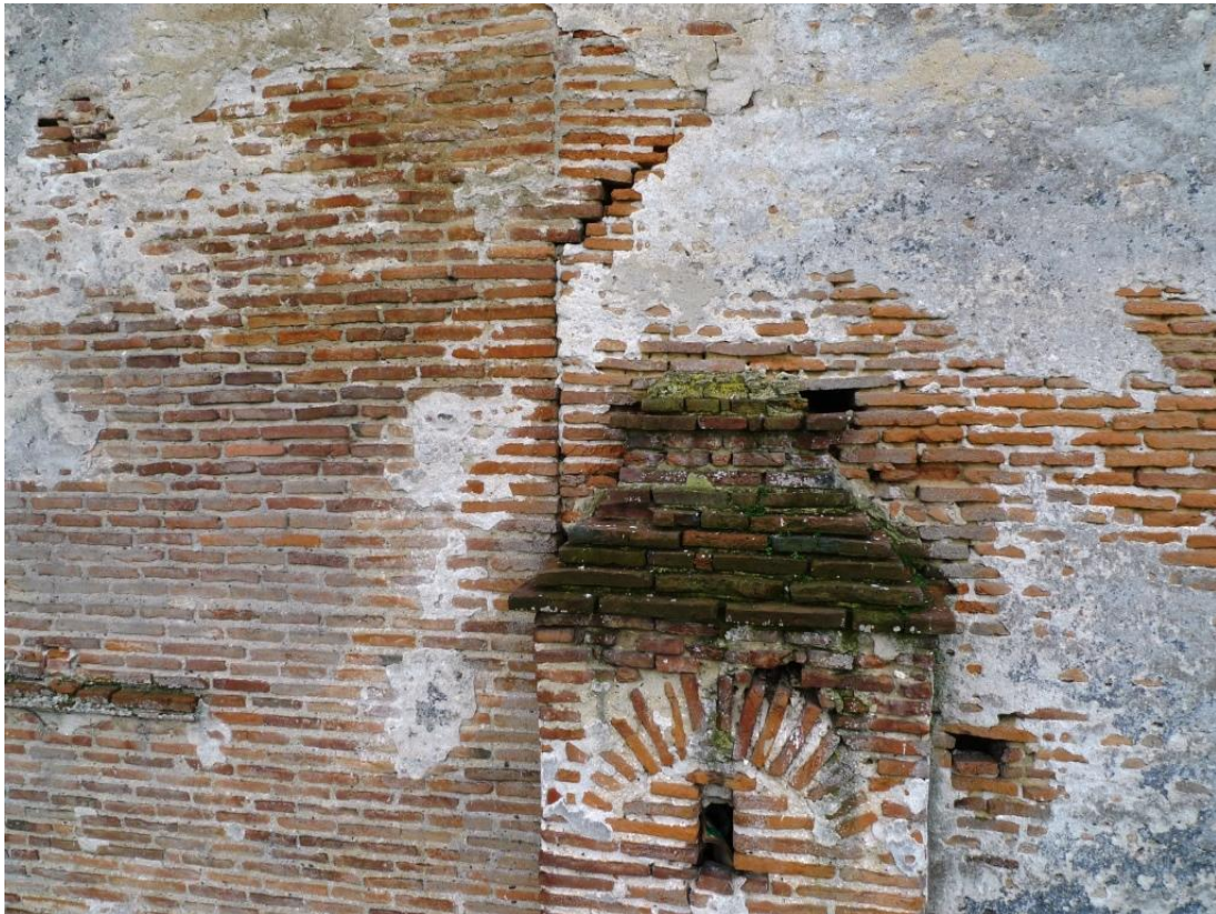
Figure 67 : Reprise de maçonnerie au-dessus des latrines (LAT 2304) avec profil de corniche moulurée.
