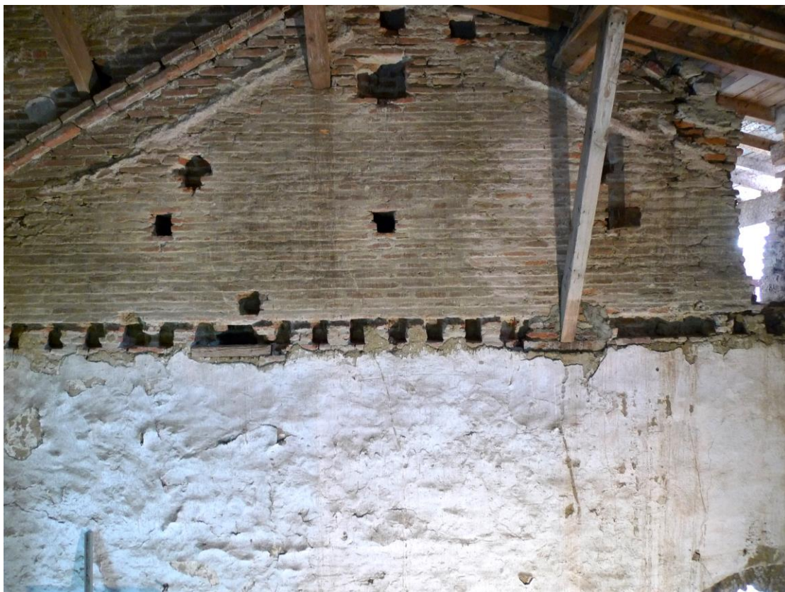
Figure 77 : Partie supérieure du mur ouest (MUR 2303).
