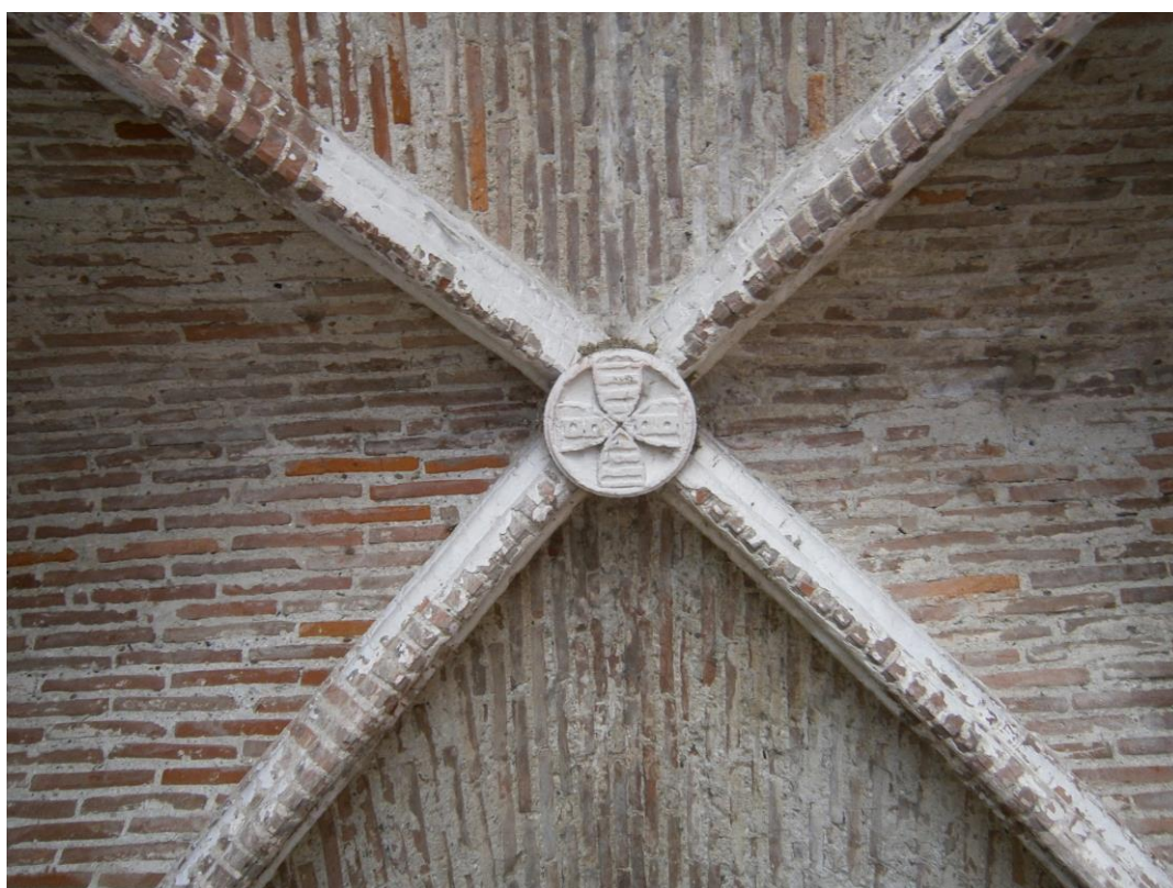
Figure 71 : Clef de voûte (VUT 1406) du porche.
