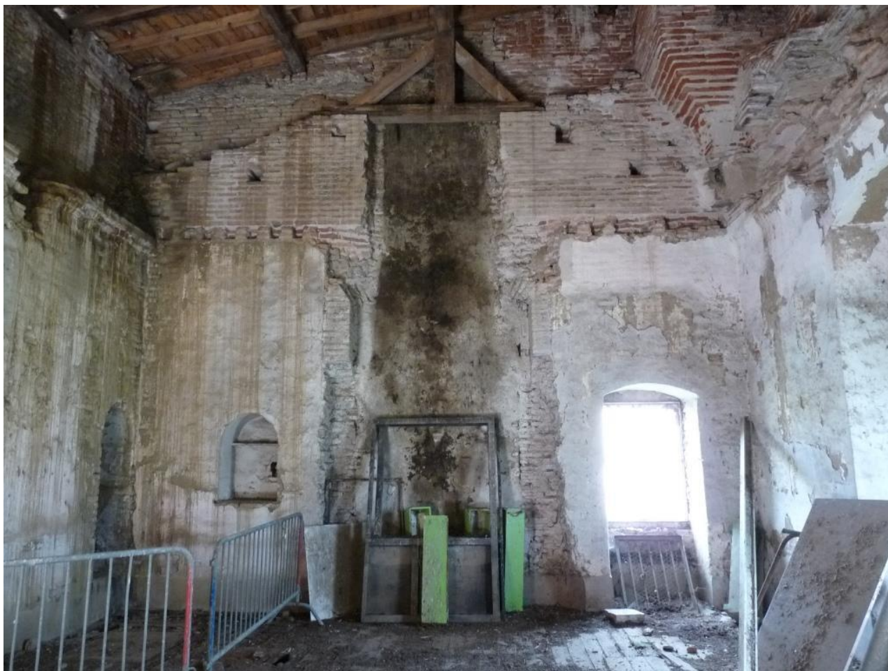
Figure 81 : Vue générale du mur pignon est (MUR 2301). En haut à droite, la base de l'échauguette sud-est. Cl. L. Gérardin.
