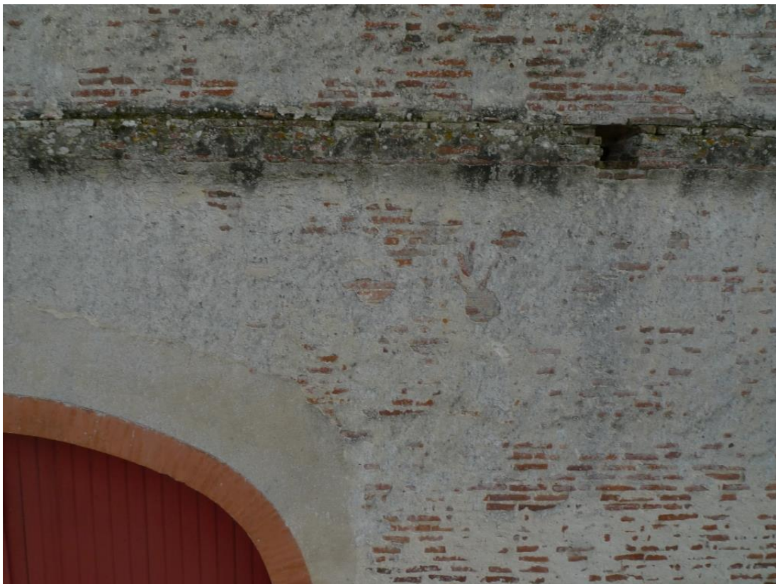
Figure 41 : Cordon d'appui sur la partie ouest de la façade.
