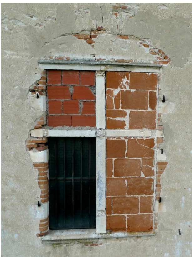
Figure 61 : Sixième croisée depuis l'ouest (FEN 2308). L'arc de décharge est le couvrement d'une ancienne fenêtre jumelée
