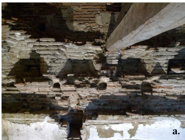
Figures 80 a, b, c : détail des anciens exutoires des eaux du toit sur le mur gouttereau sud (MUR 2302), de droite/est à gauche/ouest.
