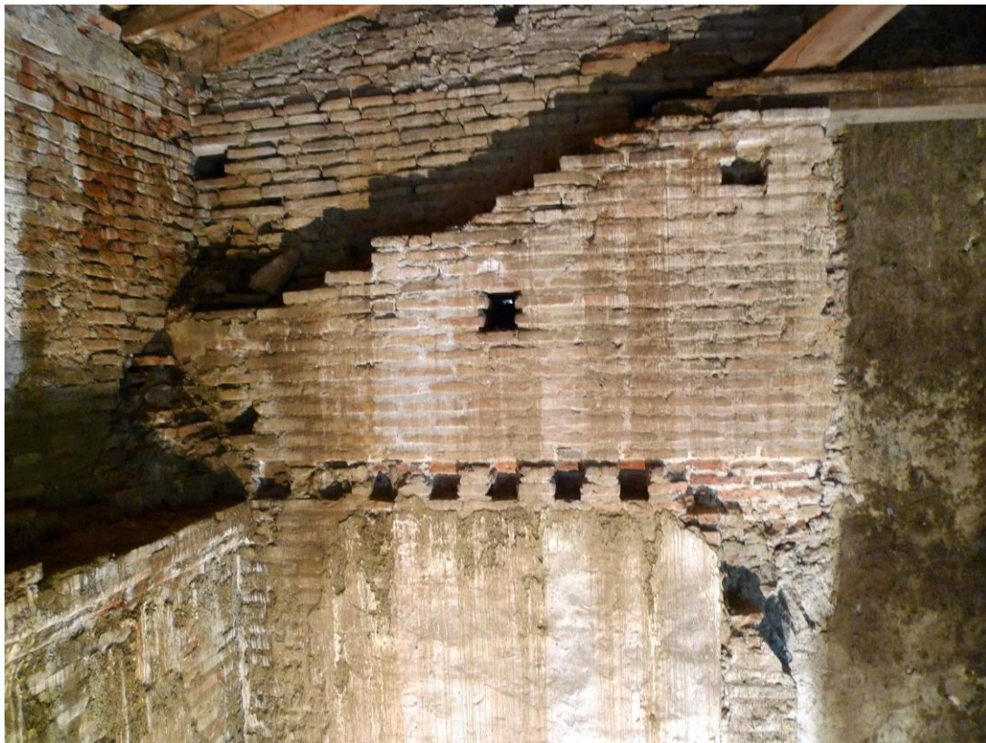
Figure 85 : Traces du pignon d'un ancien toit sur le mur est (MUR 2301) et alignement de trous solives
