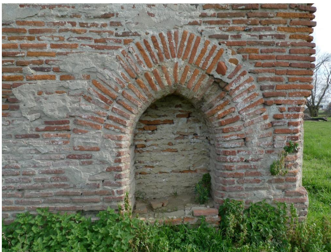
Figure 39 : Porte en arc brisé à double rouleau à l'angle ouest (POR 1805).
