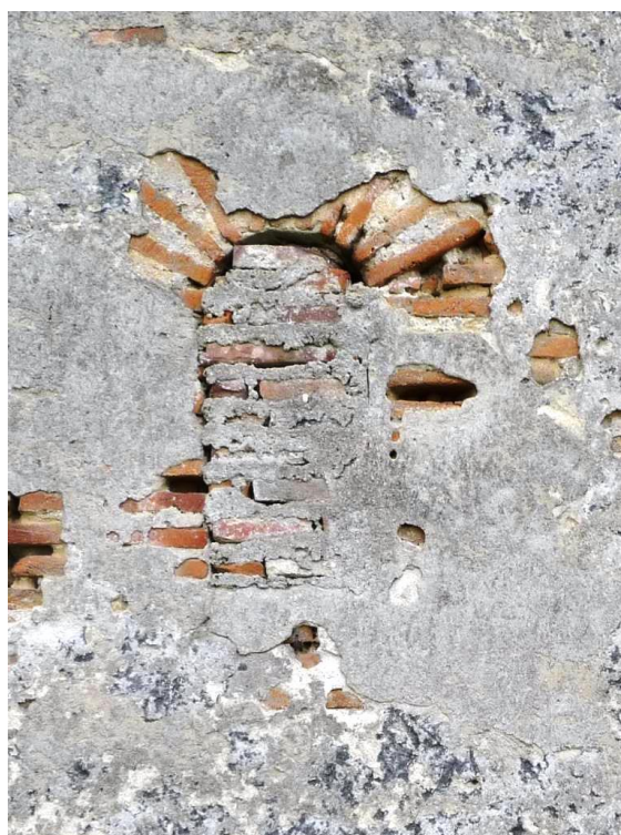
Figure 68 : Jour (JOU 2205) sud d'une série de trois jours dans la partie nord de la façade.
