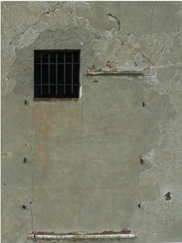
Figure 55 : Croisée ouest murée (FEN 2607)
