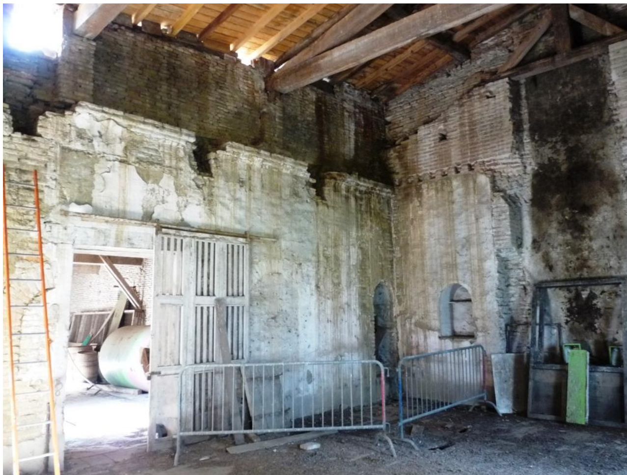
Figure 86 : Vue générale du mur nord (MUR 2203). À droite/est, accès aux latrines (LAT 2304). Cl. L. Gérardin.
