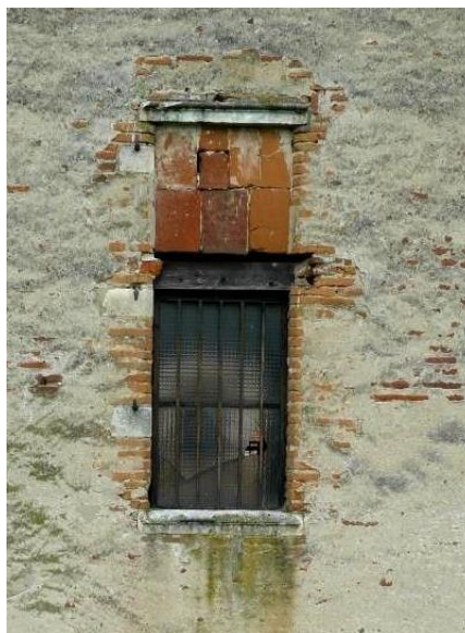
Fig. 48 : Demi-croisée détruite (FEN 2805)
