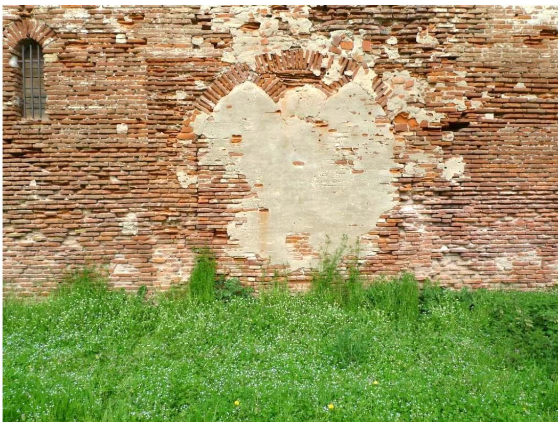
Figure 44 : Baie jumelée bouchée au sud de la façade.
