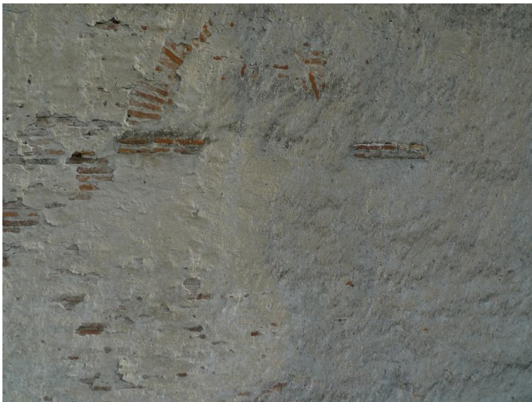
Figure 40 : Vestiges du couvrement et du cordon d'imposte d'une fenêtre jumelée.
