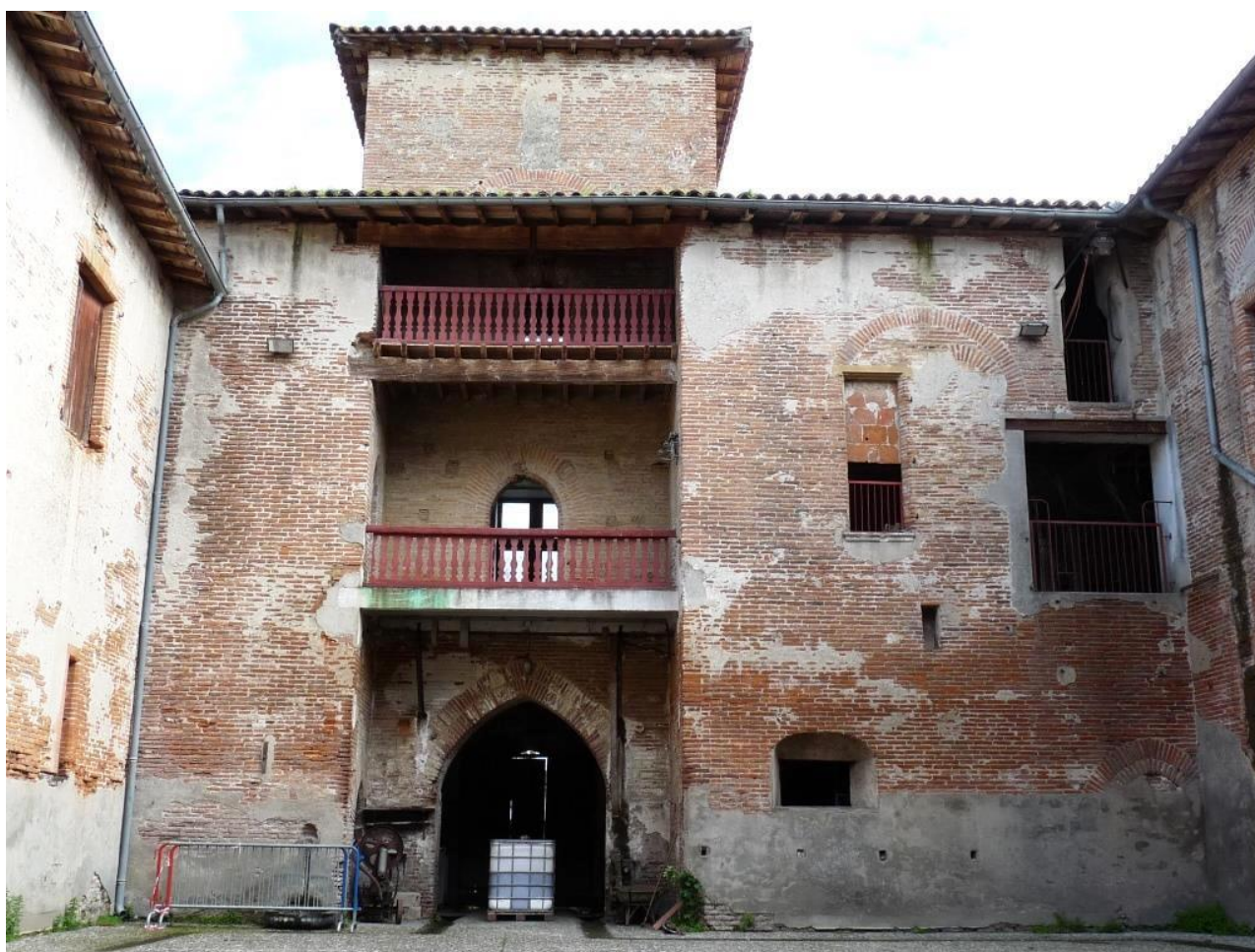
Figure 69 : Vue de la façade sud de la cour intérieure (revers nord de l'aile sud du château).
