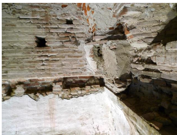
Figures 83 : Base de la trompe de l'échauguette sud-est (TUR 42)
