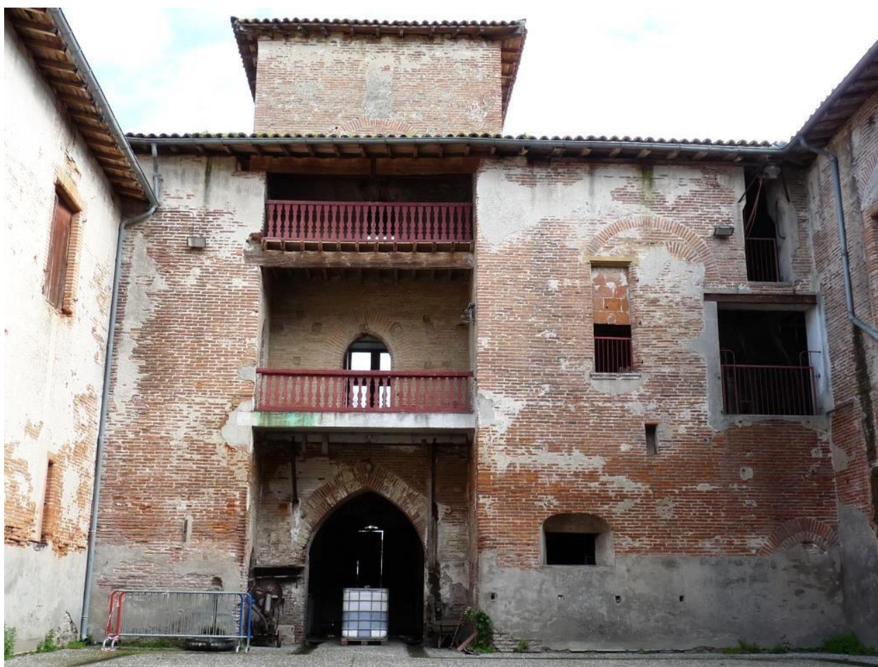
Figure 69 : Vue de la façade sud de la cour intérieure (revers nord de l'aile sud du château).
