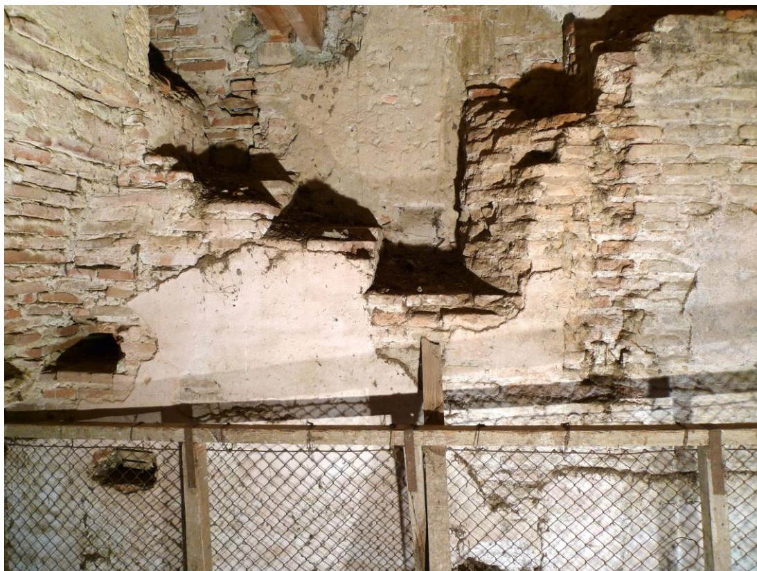
Figure 90 : Détail de l'angle sud du mur ouest (MUR 2602).
