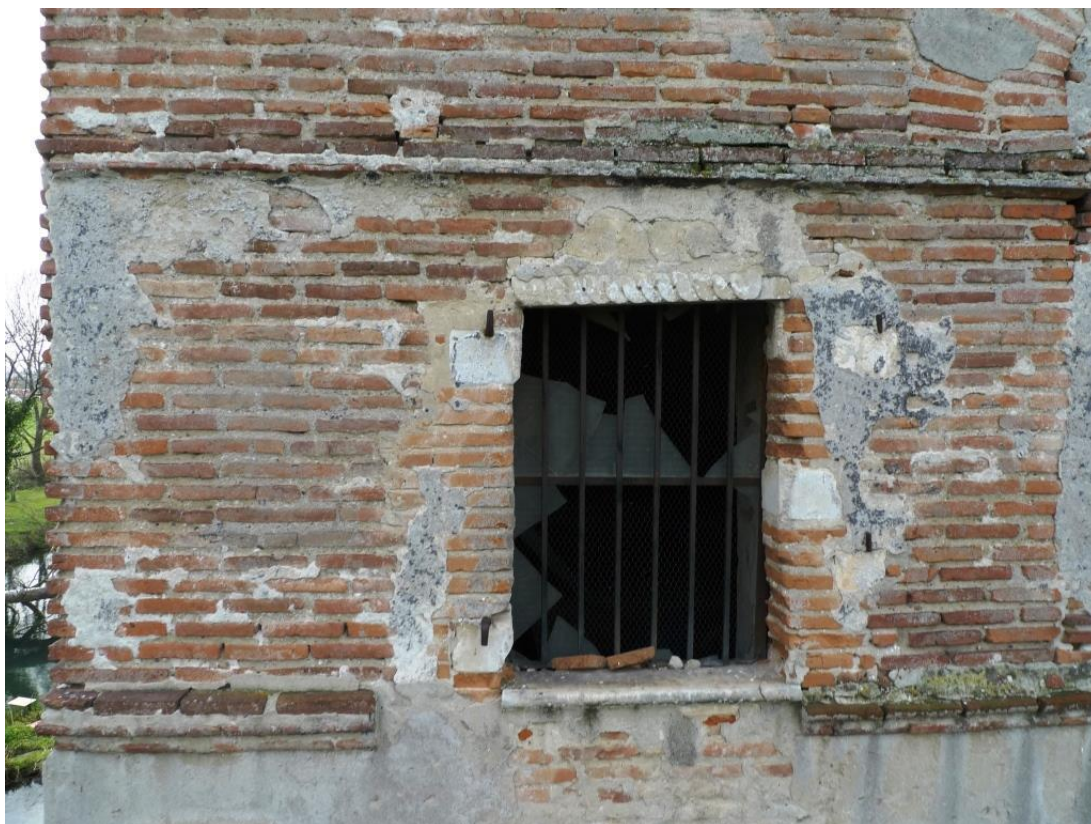
Figure 64 : Linteau en pierre moulurée en remploi sur une fenêtre du 1 er étage (FEN 2307).
