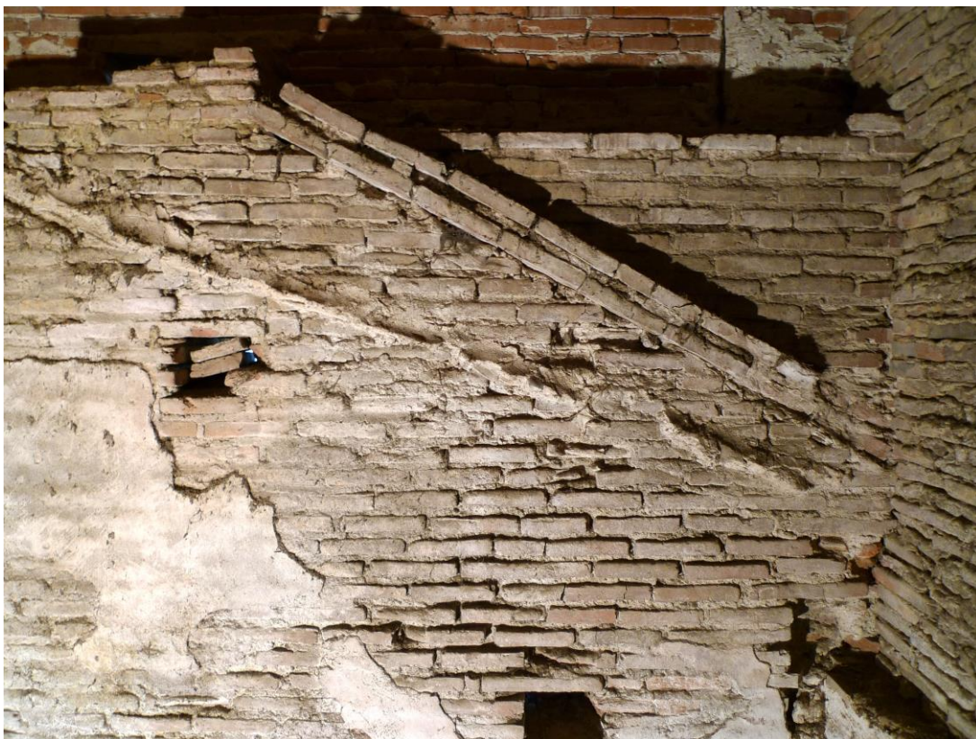
Figure 88 : Ancien pignon sur le mur ouest (MUR 2602).
