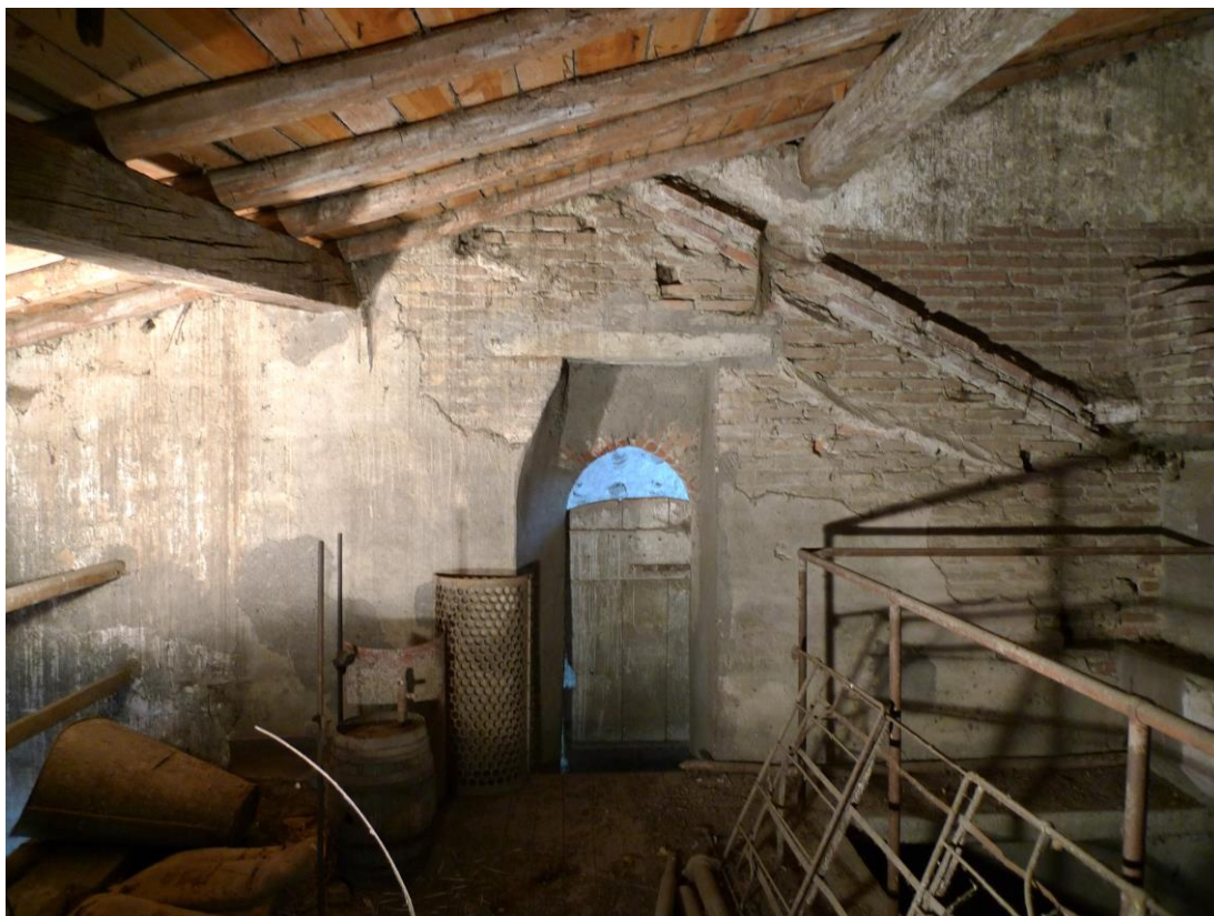
Figure 94 : Ancien pignon sur le mur est (MUR 2402) et accès à la salle haute de la tour.
