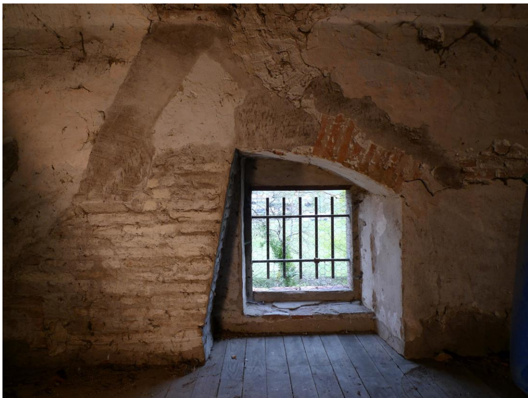
Figure 92 : Partie d'arrière-voussure d'une croisée (FEN 2607) sur le mur sud (MUR 2601).
