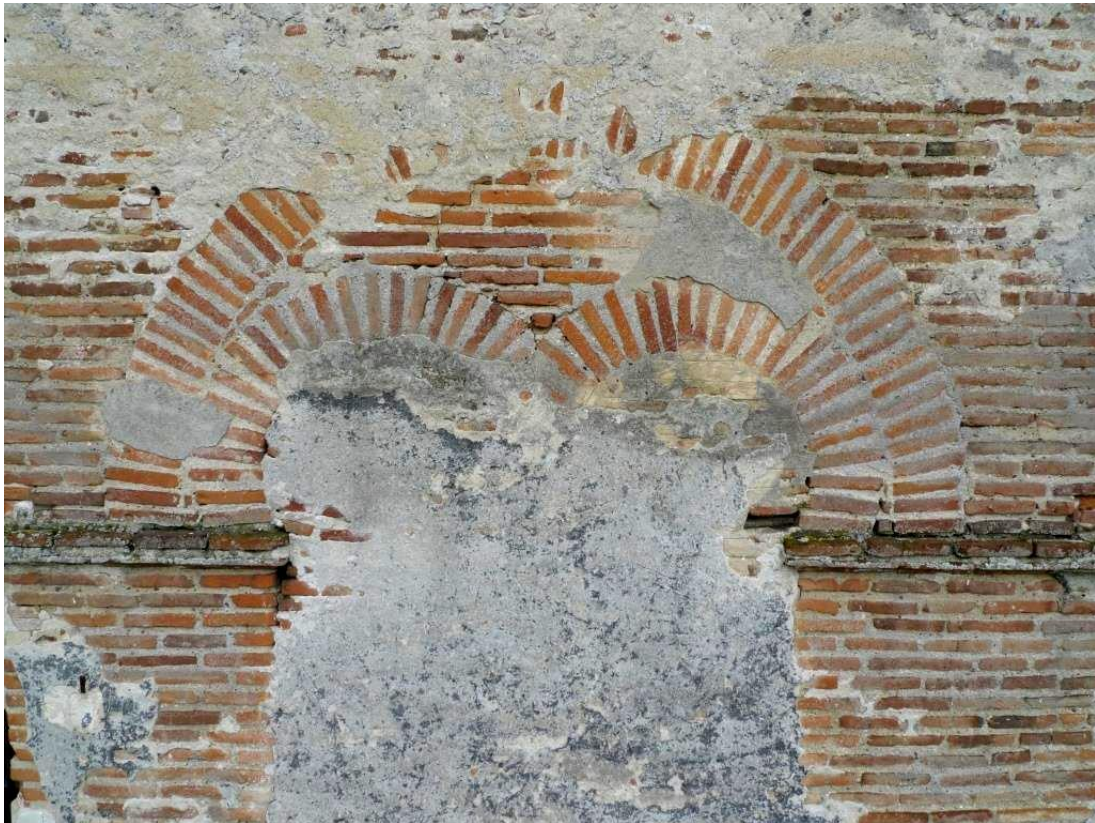
Figure 65 : Imposte et couvrement d'une fenêtre jumelée bouchée à gauche/sud de la façade, transformée en cheminée (CHE 2306).
