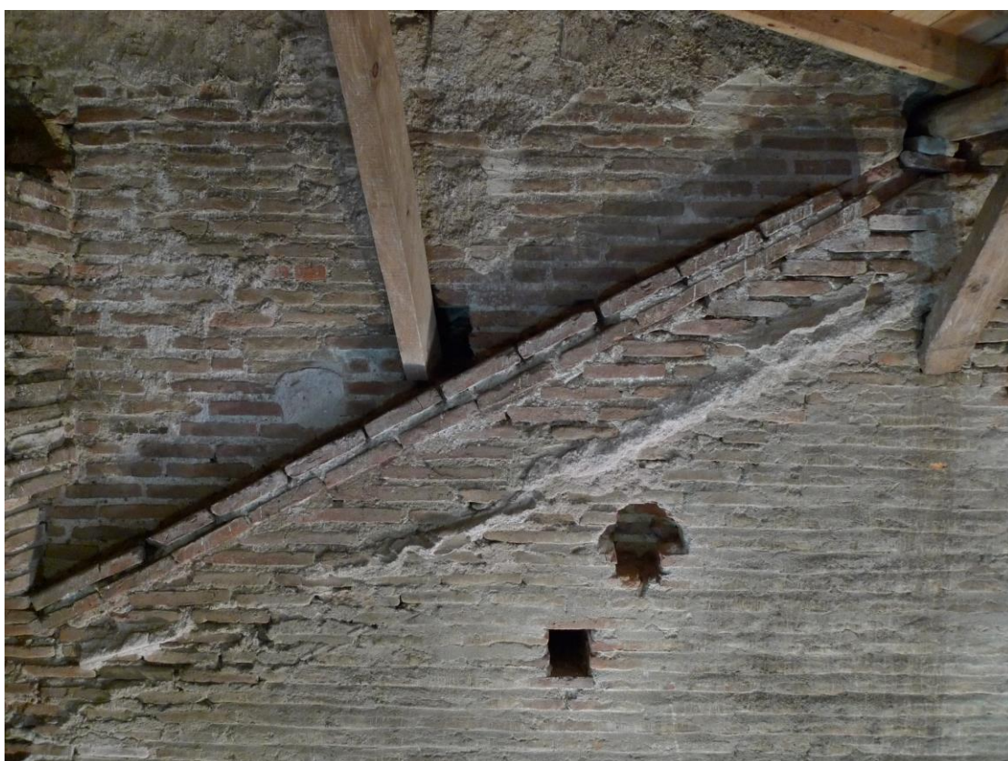
Figure 78 : Détail du mur ouest : pignon d'une ancienne toiture (MUR 2303).
