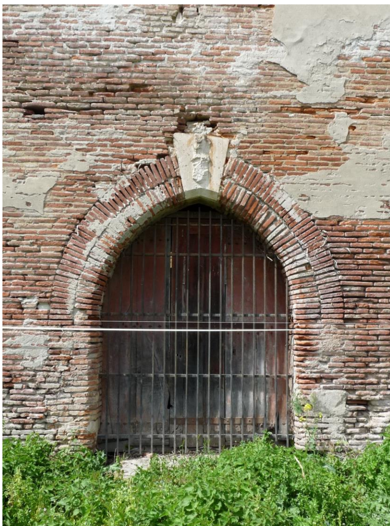
Figure 54 : Portail principal en arc brisé (POR1404)
