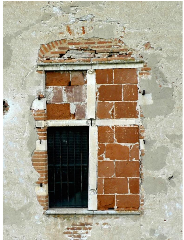
Figure 60 : Cinquième croisée depuis l'ouest (FEN 2309). L'arc de décharge est le couvrement d'une ancienne fenêtre jumelée
