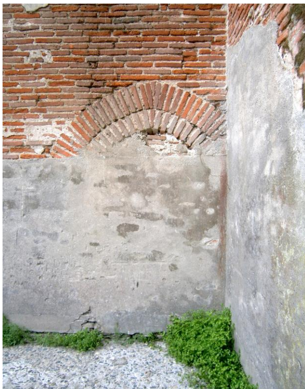
Figure 72 : Porte murée (POR 1108) à double rouleau au rez-de-chaussée, à droite/ouest.
