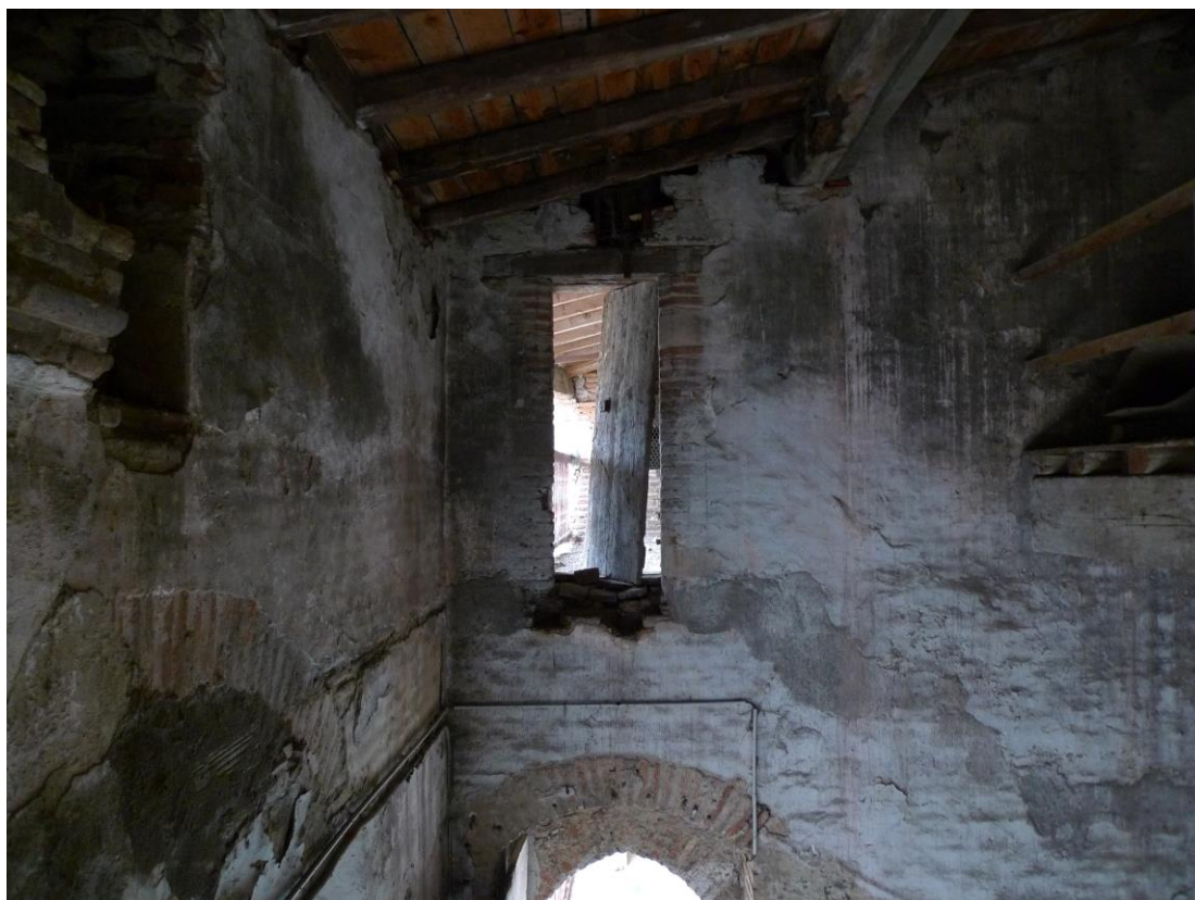
Figure 95 : Ancien accès à la galerie supérieure de la tour, à gauche/nord du mur est (MUR 2402).
