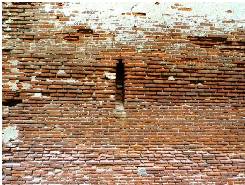
Figure 45 : jour muré au rez-de-chaussée, au sud de la façade.
