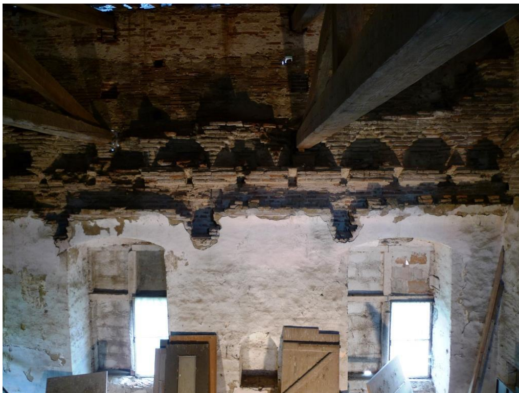
Figure 79 : Vue d'ensemble du mur sud (MUR 2302), avec les croisées FEN 2308 à gauche et FEN 2309 à droite.
