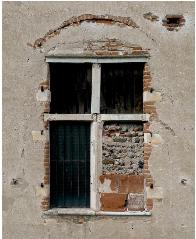
Figure 56 : Deuxième croisée en partant de l'ouest (FEN 2606) l'arc de décharge est le couvrement d'une ancienne fenêtre jumelée
