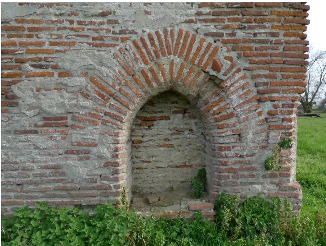
Figure 39 : Porte en arc brisé à double rouleau à l'angle ouest (POR 1805).
