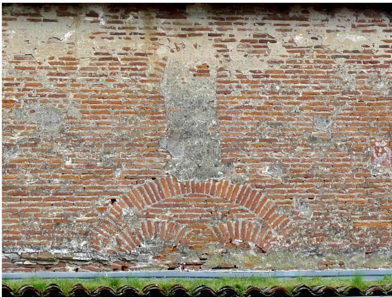
Figure 74 : Couvrement d'une fenêtre jumelée sur la face nord de la tour de l'aile sud, coupée par la toiture actuelle et surmontée d'une petite baie bouchée.
