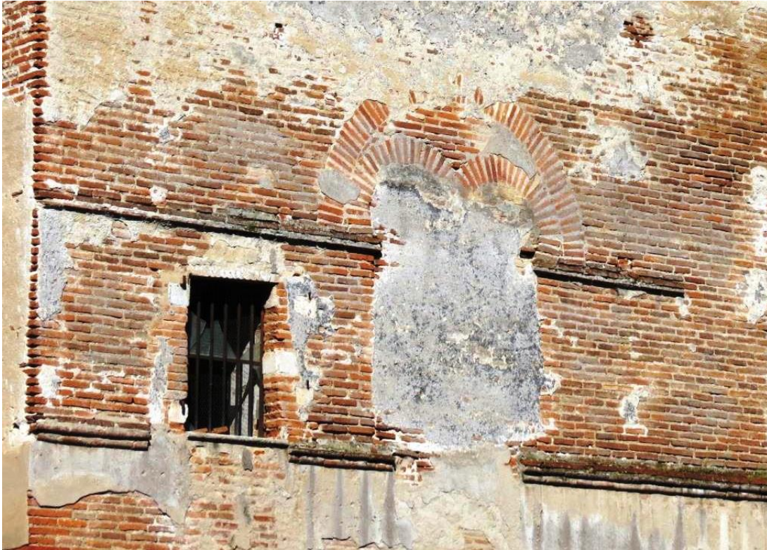
Figure 51 : Fenêtre géminée (2306) à arcs outrepassés sur la façade est avec cordons d'appui et d'imposte régnants, bûchés à partir de l'angle sud (à gauche).
