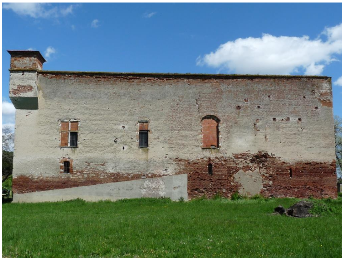
Figure 28 : Vue générale de la façade ouest.
