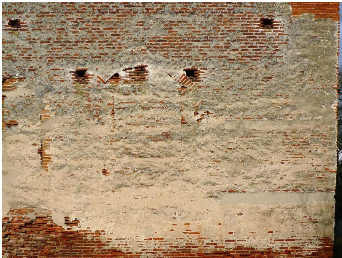
Figure 43 : Au centre, l'arc de l'ancienne fenêtre géminée (2612). À droite, deux traces d'enduit matérialisent l'emplacement des anciens cordons d'appui et d'imposte régnants.
