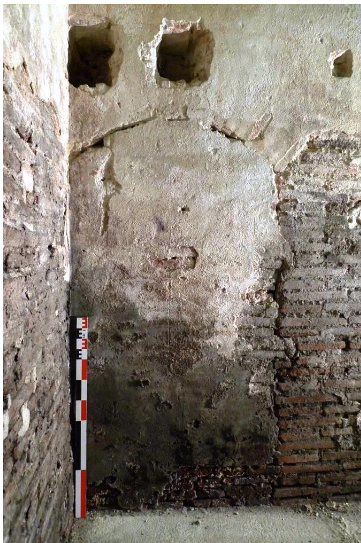
Figure 70 : Arrière-voissure de la porte 1805, au rez-de-chaussée de l'aile ouest.
