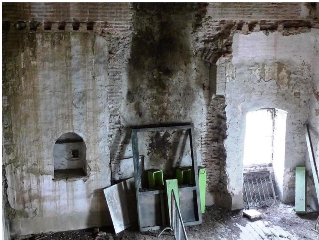
Figure 98 : Niche à gauche/nord de l'ancienne fenêtre géminée transformée en cheminée (2306).
