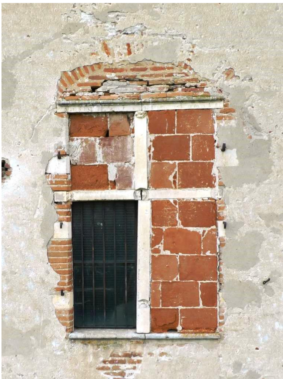
Figure 52 (à gauche) : Croisée (2309) du XVII e sur la façade sud, couverte par l'arc d'une ancienne fenêtre géminée.
