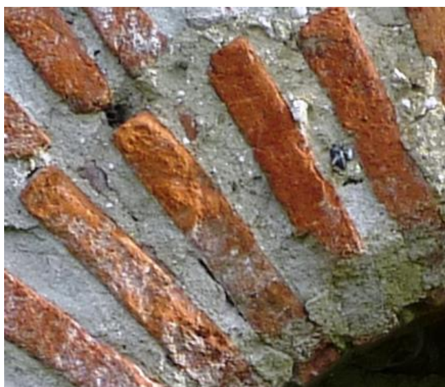
Figure 71 : Joint des briques du rouleau inférieur de la porte 1805.
