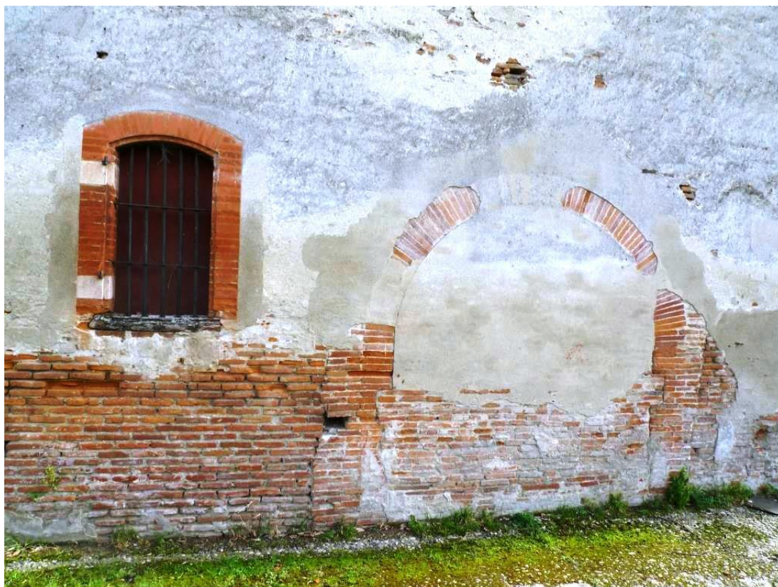
Figure 102 : Jour 1205 et portail bouché, percés dans la façade nord au XVII e siècle.
