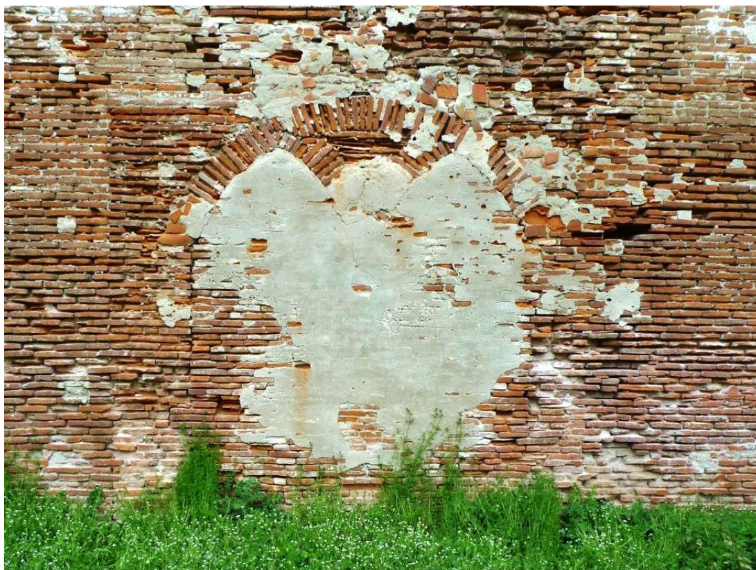
Figure 36 : La baie 1608, rez-de-chaussée de la façade ouest.
