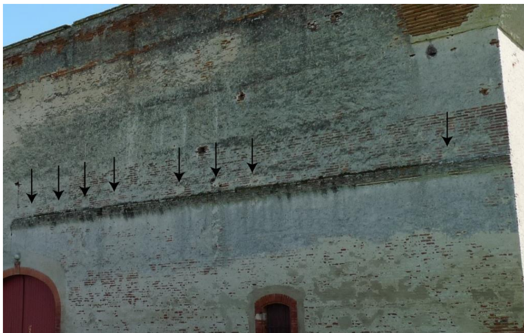
Figure 89 : Repérage d'exutoires bouchés au-dessus de la corniche moulurée de la façade nord, ancien mur gouttereau nord du bâtiment B détruit.
