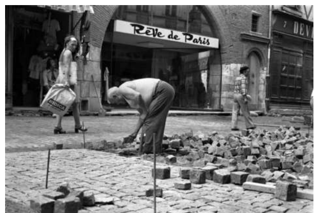
Pietonnisation de la rue Saint-Rome, août 1974, direction de la Communication – Ville de Toulouse, Archives municipales, 15Fi2189/5.
