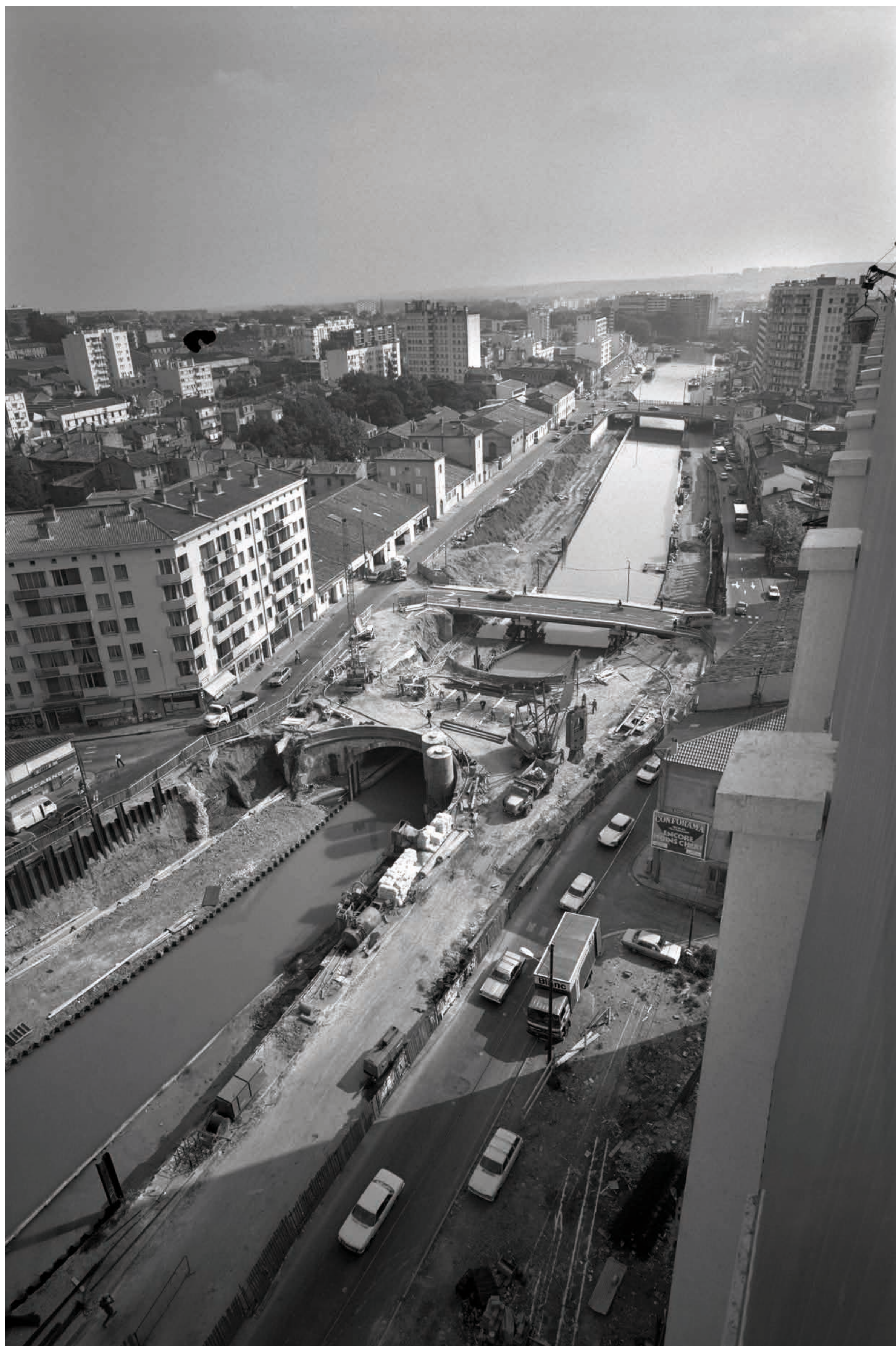
Au premier plan, l'ouvrage en construction. Au second plan, le port Saint-Étienne entre les deux ponts déjà bâtis, où se distingue, à gauche, le château du canal, magasin de stockage flanqué de deux tours ayant abrité la chambre de justice et une prison. Reportage photographique sur la reconstruction du pont et les travaux d'aménagement des voies sur berges effectué pour le magazine municipal Capitole Infos de la direction de la communication de la Ville de Toulouse.
